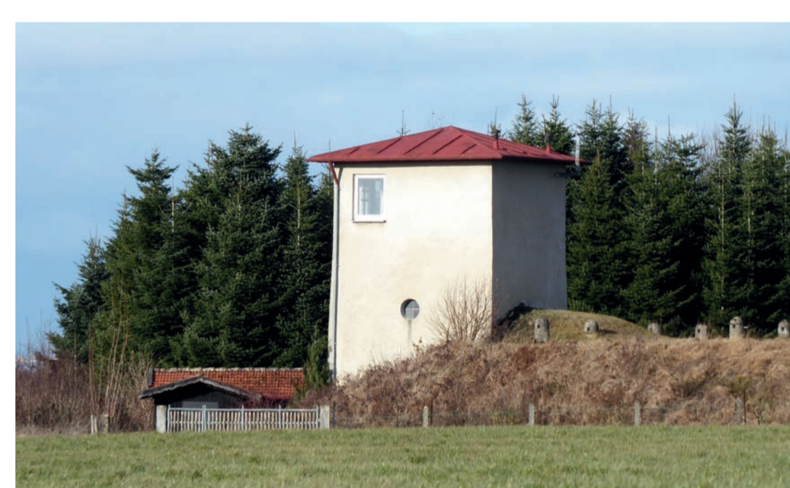
Turm mit Hochbehälterhügel, Ansicht von Süden
